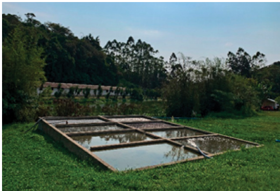
Figura 11. Decantador ligado a um biodigestor em uma granja comercial de suínos
